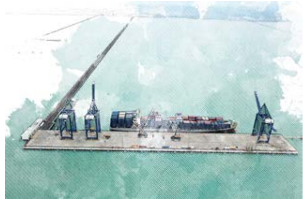
2019 Pengawas Pembangunan Terminal Multipurpose dan Fasilitas Pendukung di Pelabuhan Kuala Tanjung, Batu Bara, Sumatera Utara
